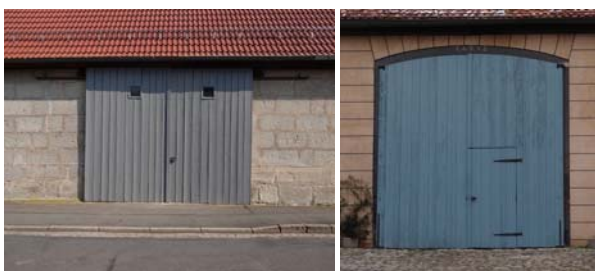
Einfaches, funktionales Scheunentor zum Aufschieben. Die Sandsteinfassade dokumentiert den Gebrauch! Links Schönes traditionell gestaltetes Holztor rechts
