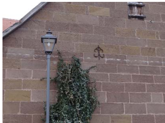
Sandstein steinsichtig vermauert bei Scheunen u.a. Nebengebäuden. Auf den Kalkfugenmörtel, farblich abgestimmt und genauso hart wie der Sandstein, darauf kommt es an! Fassadenanker zur Befestigung der Zwischendecke
