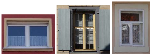
Kunststofffenster mit Mittelkämpfer links, Holzfenster mit Holzklappläden mitte, Holzfenster mit Winterfenster rechts
