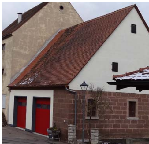
Steinsichtige Fassade mit verputztem Giebel und ruhiger Dachfläche
