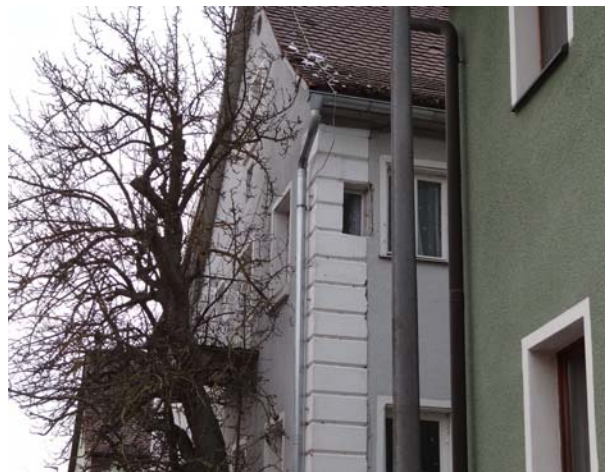
Liebevoll gestaltete Eigenarten erhalten.
