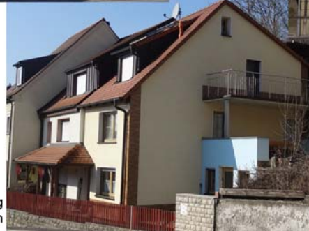
Eineinhalbgeschossig mit Frackdach
