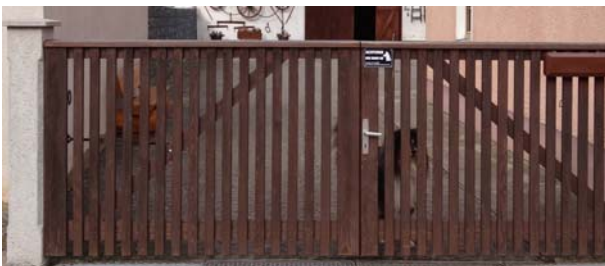
Hölzernes Hoftor aus einzelnen Latten, Pfosten aus Stein
