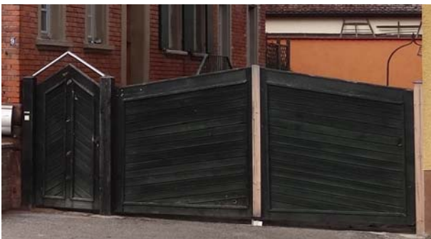
Hölzernes blickdichtes, aber überschaubares Tor mit separater, betonter Pforte
