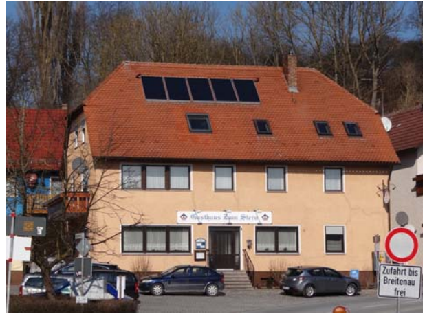
Photothermie- / Solarthermiezellen zur Warmwasseraufbereitung
