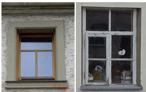
Modernes dreigeteiltes Holzfenster mit Sandsteingewänden links. Historisches zweiflügeliges Holzfenster mit feststehendem Oberlicht rechts.
